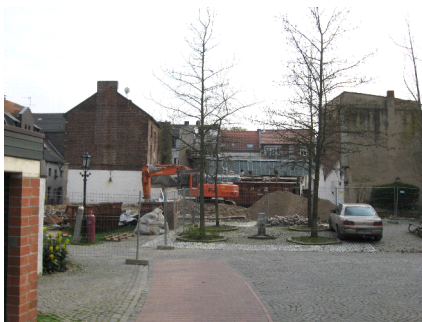
ESG-Quartier „Mondhöfchen“ während den Abrissarbeiten Quelle: Quaestio
