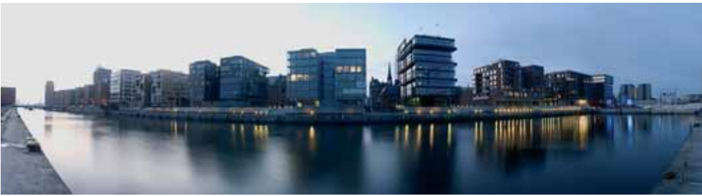
Abb. 20: Großwohnprojekt des neuen Jahrtausends - die HafenCity in Hamburg
