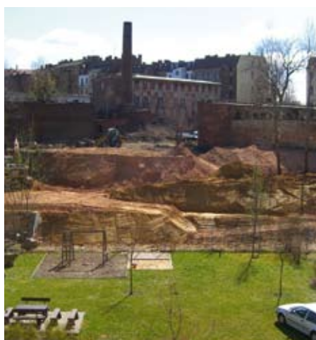
Rückbau von Gewerbebauten im Hofinnenbereich.
